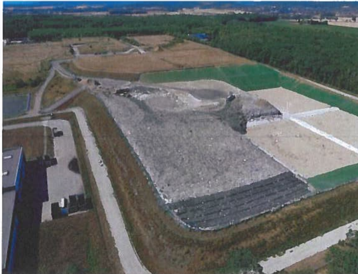
Figure 5 Bis : Vue aérienne des casiers de stockage au SMET (Chagny)
