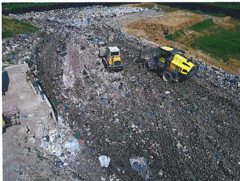
Figure 5 : Compaction des OMR* sur les casiers de stockage au SMET (Chagny)
