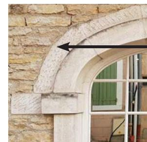
Encadrement en relief. Le mur doit être enduit ainsi que la pierre bouchardée.
