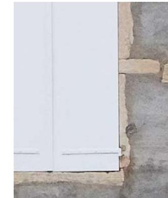
le harpage doit être dissimulé.
